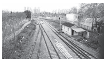
自天橋俯瞰斑駁鐵道。
