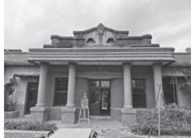
坐北朝南的美濃警察分駐所，是一棟土黃色的磚木混合的日式建築，正面建築外觀仍保持完好，也可見當時選材的謹慎與建造的用心。此分駐所是當時美濃的政經中心，主體以台灣檜木建造，入口處有四根圓柱，成為支撐起巴洛克建築風格的山牆底柱；山牆最上方的橢圓型徽章，裝飾著綵帶、繩索的圖樣，徽章下方還有兩個圓形牛眼窗，十分特別。分駐所內部有連通走廊，左右兩側是當時的警察辦公處及
